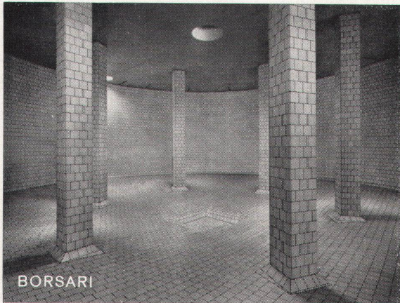
Flughafen-Immobilien-Gesellschaft Zürich-Kloten 7 Tanks total 5600 m 3 Schweröl
