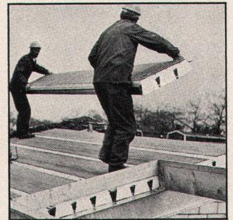
Holorib DLW sind Dachelemente mit maximaler Belastungsfähigkeit, in Längen von 2,5 bis 8,0 m, mit geringem Eigengewicht (20,5 bis 33,5 kg/cm², je nach Beschichtung), mit hoher Isolationsfähigkeit (K-Wert 0.40)
