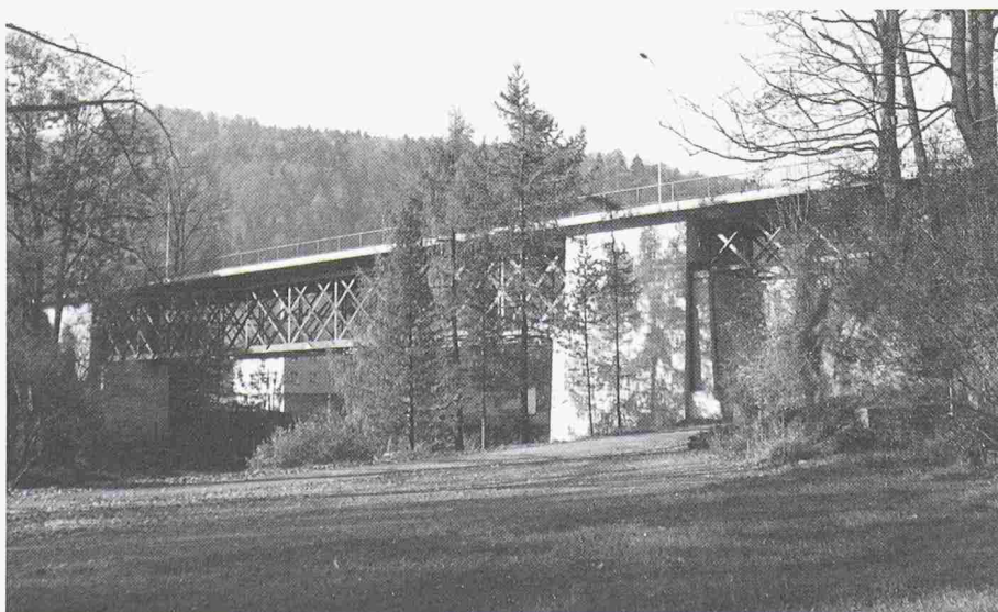
Thurbrücke bei Lichtensteig, erbaut 1870, umgebaut 1981
