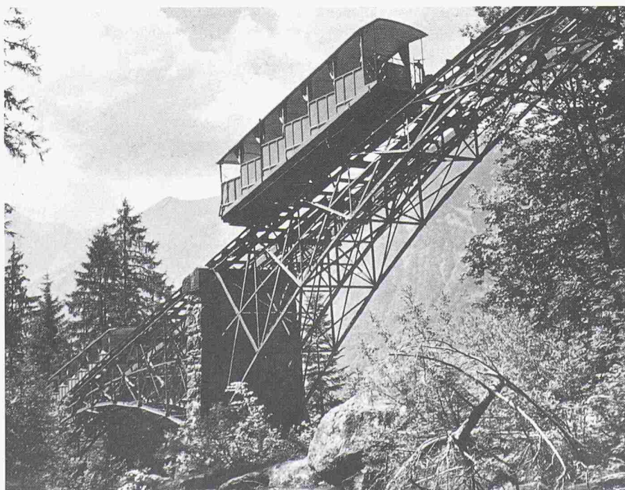
Die Giessbachbahn überquert auf fünf total 174 m langen schweisseisernen Brücken das romantische Tobel. Die Felder bei der Ausweiche besitzen drei Hauptträger
