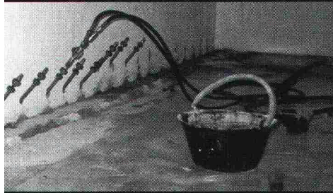
Elastische Abdichtungs-Injektion-Rascoflex in einer Zivilschutzanlage.
