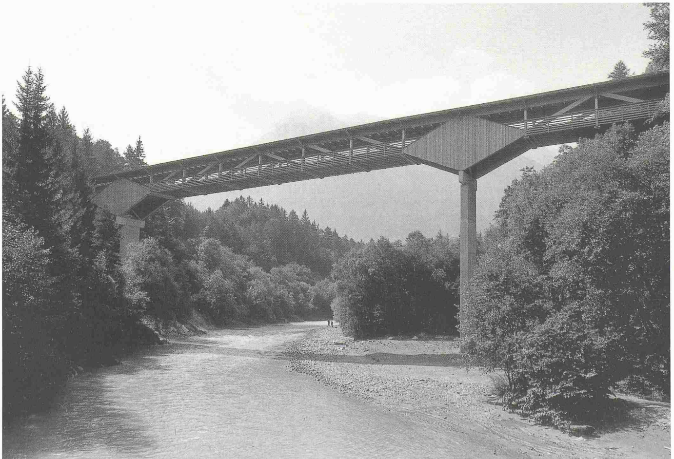
Bild 9. Über 20 m hoch überspannt die in den Wald eingebettete Brücke die Simme
