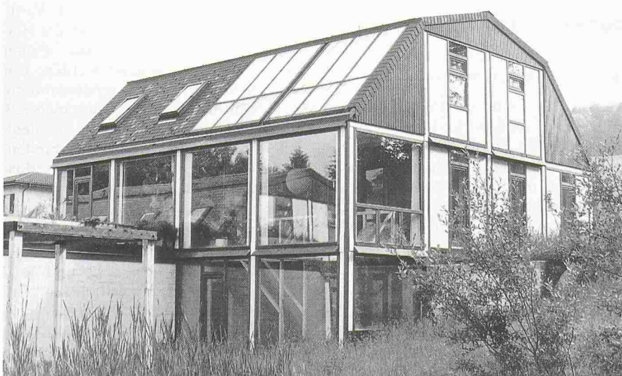
Das Interesse an Solartechnik wächst stetig (Bild: Comet)
