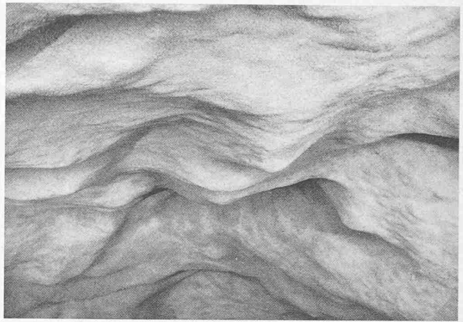
Bild 6. Stütz- und Schutzschicht aus Spritzbeton; man beachte die in groben Zügen nachgezeichnete Struktur der Felsoberfläche
