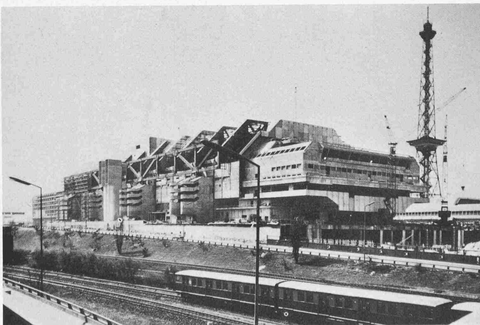
Blick von Nordosten, Haupteingangspartie, Verwaltung, Restaurant, Küche
