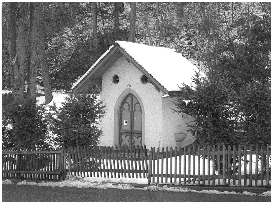
Die 1855 errichtete Brunnenstube am nördlichen Rand der «Rosenhügel»-Anlage (Aufnahme Dezember 2008).
