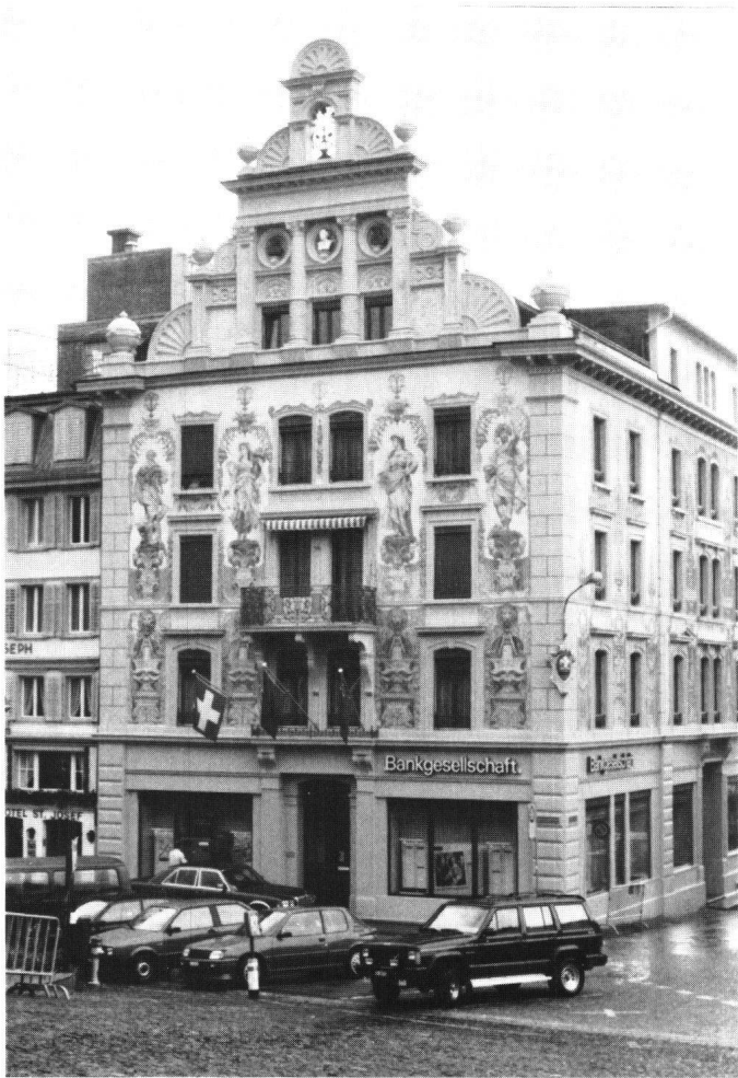
Abbildung 38 Einsiedeln, Haus Ilge. Die Architekturbemalung wurde anhand des Befundes wiederhergestellt. Heute besteht wieder ein Gleichgewicht zwischen der Architekturbemalung und der Camailleu-Malerei in den Zwischenfeldern.
