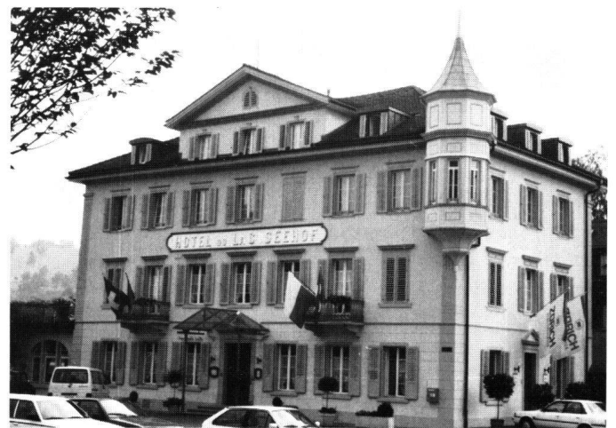
Abbildung 40 Küssnacht, Seehof. Die Hauptfront nach der Restaurierung.
