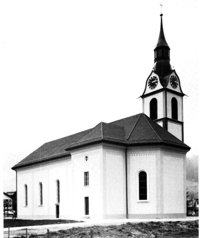
Abbildung 23 Unteriberg, Pfarrkirche St. Joseph. Die wiederhergestellte Gliederung an Fassaden und Turm.
