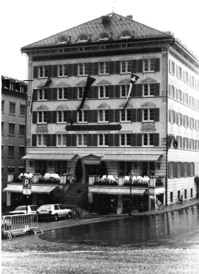
Abbildung 39 Einsiedeln, Pfauen. Die Hauptfront mit rekonstruierter Fassadenmalerei.
