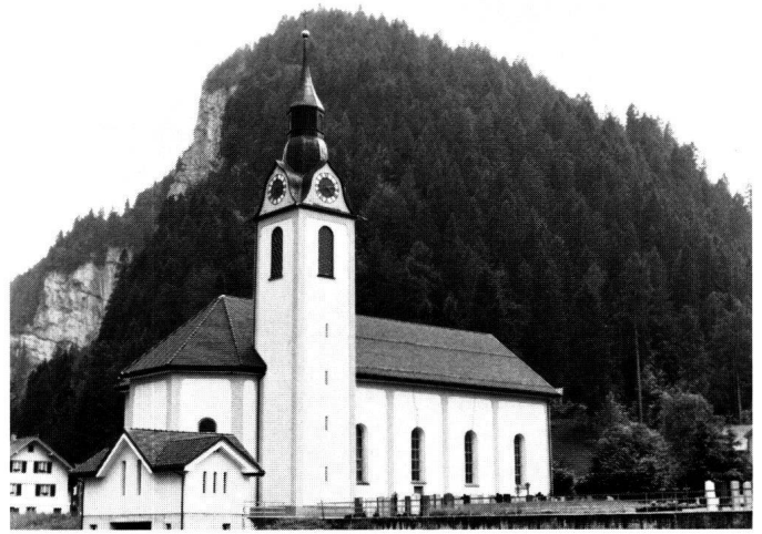
Abbildung 22 Unteriberg, Pfarrkirche St. Joseph. Choransicht, in den 60er-Jahren wurden die aufgemörtelten Fassadengliederungen und die reich profilierte Dachuntersicht entfernt.
