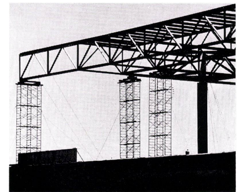
9-15 Errichtung der Dachkonstruktion. Mise on œuvre de la toiture. Erection of the roof construction.
