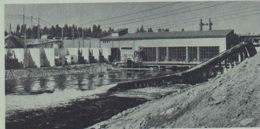
Bild 8. Kraftwerk von Unterwasserseite; rechts Flösrinne, links Schaltanlage
