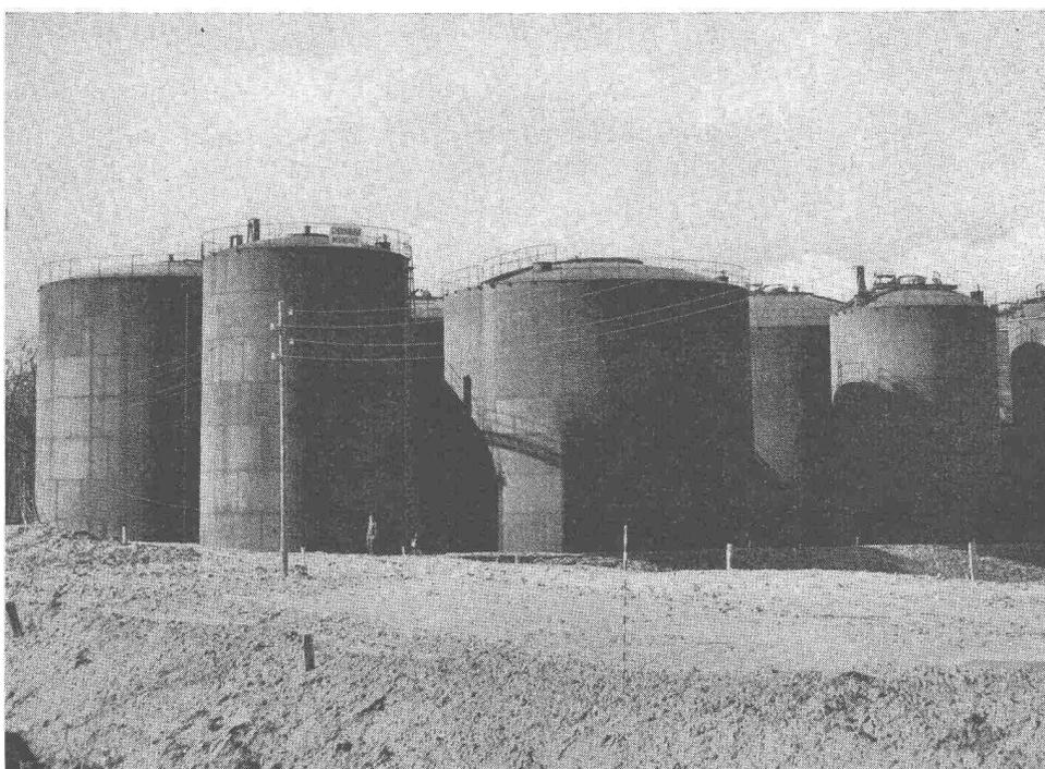
Série de 7 réservoirs pour stockage de mazout et de benzine avec fonds brevetés Giovanola. Capacité totale 16 000 m<sup>3</sup>. Réservoirs de benzine construits pour une pression de service de 0,2 atm.
