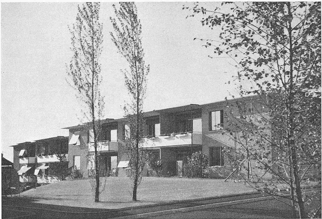
Block 2 aus Südosten
