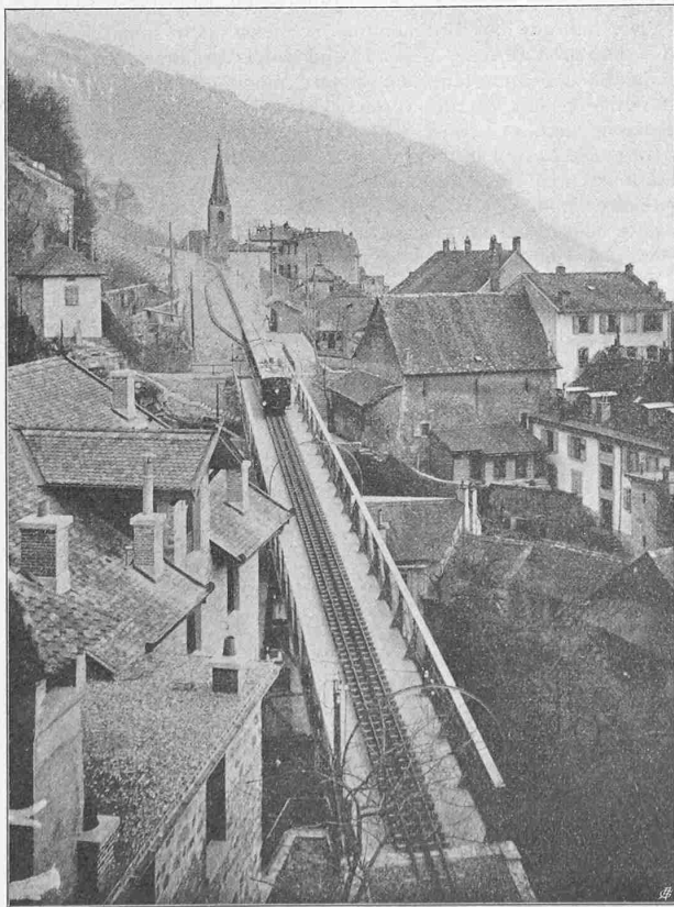
Abb. 28. Chauderon-Brücke und Haltestelle «Les Planches».
