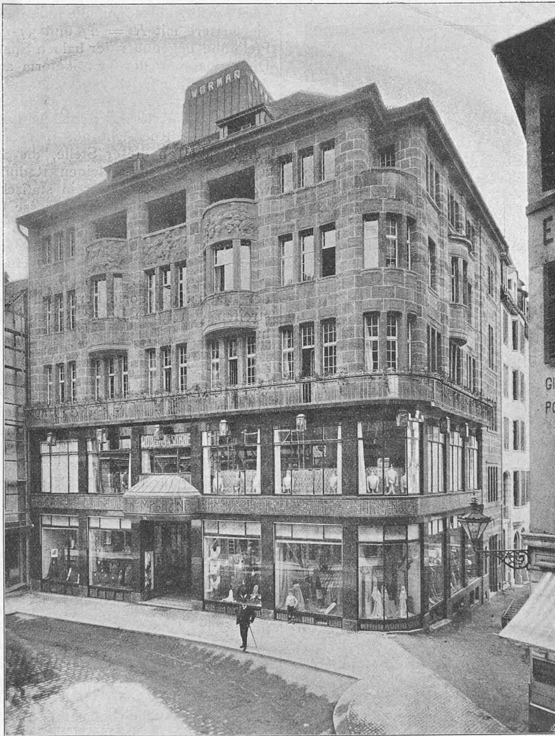
Abb. 8. Gesamtansicht von der Eisengasse aus.
