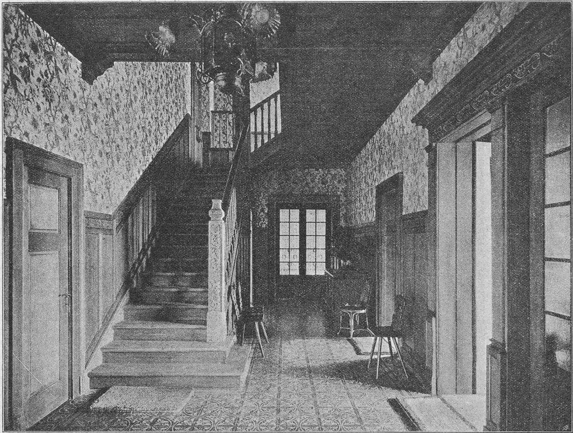
Abb. 7. Diele und Treppenhaus im Erdgeschoss. — Blick gegen Norden.
