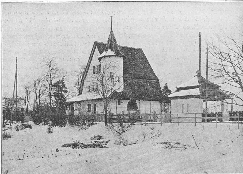
Abb. 4. Ansicht von Südwesten.
