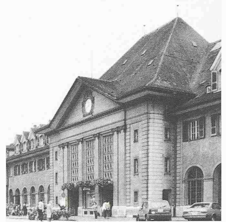
Bild 13. Das Aufnahmegebäude der SBB ist der wichtigste Bau des Quartiers. Sein Eingangsportal schliesst die Bahnhofstrasse ab und bildet Ausgangs- und Endpunkt der Achse zum Schloss
