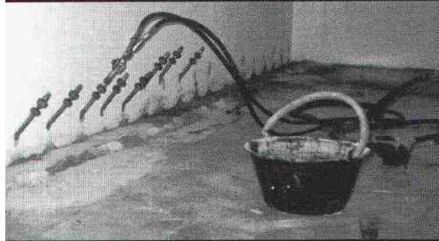
Elastische Abdichtungs-Injektion-Rascorflex in einer Zivilschutzanlage.
