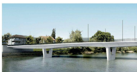
07 «Houdini»: Die Brücke besteht aus einem zweistufigen vorgespannten Plattenbalken mit schlanken, nach innen geneigten Stegen. Die Trägerhöhe nimmt in den Seitenfeldern linear gegen die Pfeiler hin zu, im Mittelfeld ist sie parabolisch überhöht. Die Pfeiler sind im oberen Teil Y-förmig aufgelöst
