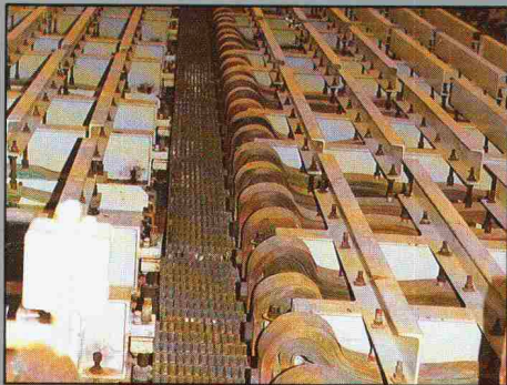
ELEKTROLYSE Dehnungsbänder mit pressgeschweißten Anschlussflächen, für die Einspeisung von Elektrolysezellen.
