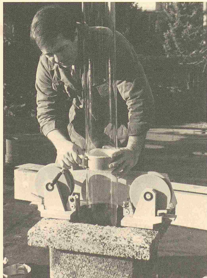
Einbau des Recusist-Kamin-Innenrohres
