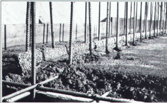
Erstellen einer Anschluss-Dichtung "BFL-MASTIX" Typ 20/70 R4.
