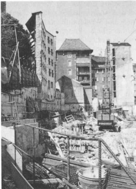
Genf, Altstadt, Sanierung
