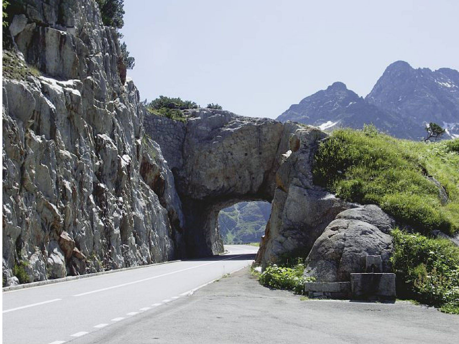
Himmelrucktunnel bei km 24 bergwärts. Der vordere Teil des Zwillingtunnels, der durch eine Lücke im Deckengewölbe charakterisiert war, ist nicht mehr erhalten. – Bild: Isabel Haupt
