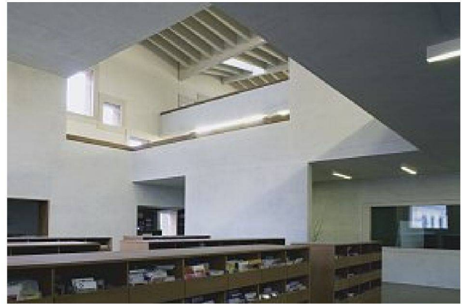
Einraum mit Galerien, Brüstungen und Dachtragwerk
