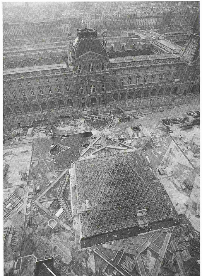
Baustelle. Pyramide, Louvre-Seitenflügel
