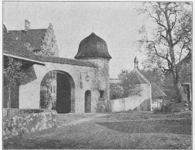
Abb. 6. Neue Toreinfahrt und Umfassungsmauer.
