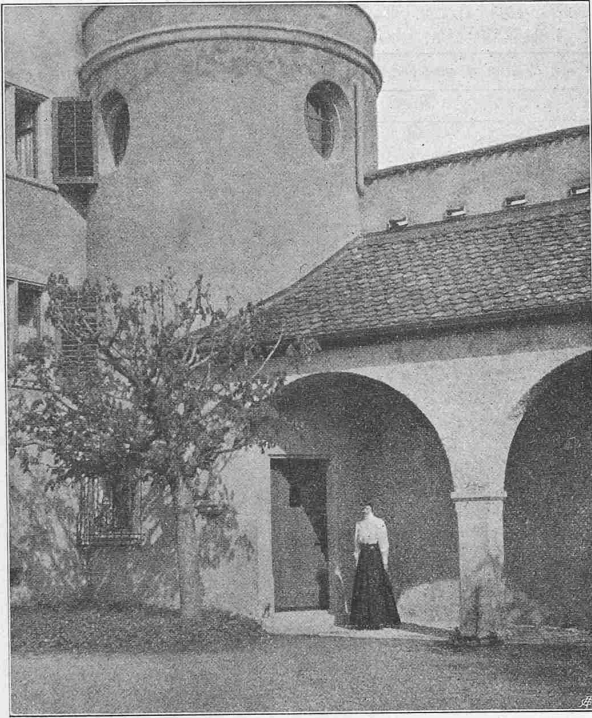
Abb. 7. Neuer Eingangsturm und Vorhalle.
