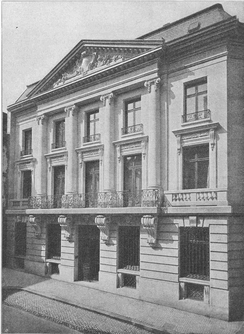
Abb. 5. Fassade an der Freiestrasse.
