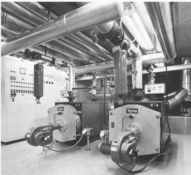
Bild 12. Klimazentrale: eine der zwei Monoblockanlagen zur Primärluftaufbereitung
