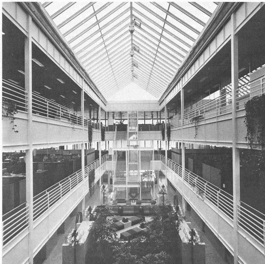
struktur gewählt, um zwischen den Stockwerken viel Raum für die technische Ausrüstung zu schaffen: Lüftungskanäle, Brandschutzanlagen, Stark- und Schwachstromleitungen usw.
