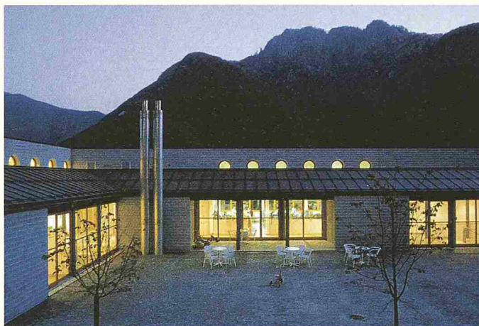
Der an der Piazza gelegene Eingangsbereich des CSO (Bild: CSO/Simonetti)
