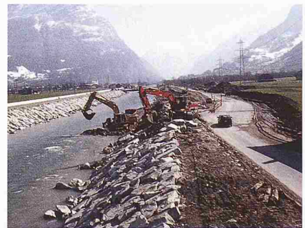
1 Verschiebung des Reussdammes (Bild: Irène Elber)
