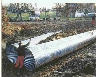
Montage eines HAMCO-Wellstahlrohres in Ermensee, Kt. Luzern.
