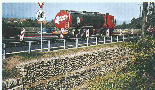
Verlängerung der Ausfahrt A1 Rastplatz Kölliken Süd, Böschung- sicherung
