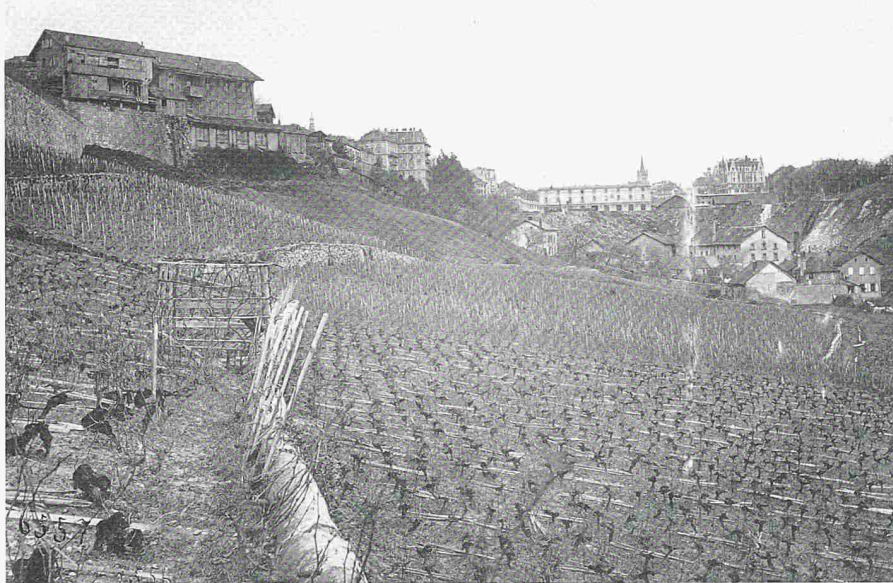
La vallée du Flon en 1904, encore partiellement plantée de vignes, alors que les travaux de comblement sont presque achevés. On distingue, en direction de Saint-François, les entrepôts déjà réalisés sur la plateforme
