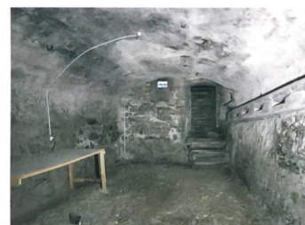
110 Unterseen, Obere Gasse 6
