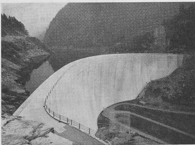
Bild 1. Ausgleichsbecken Malvaglia von 4,1 Mio m 3 Nutzinhalt mit Bogenstaumauer von 92 m Höhe, Kubatur 164 000 m 3
