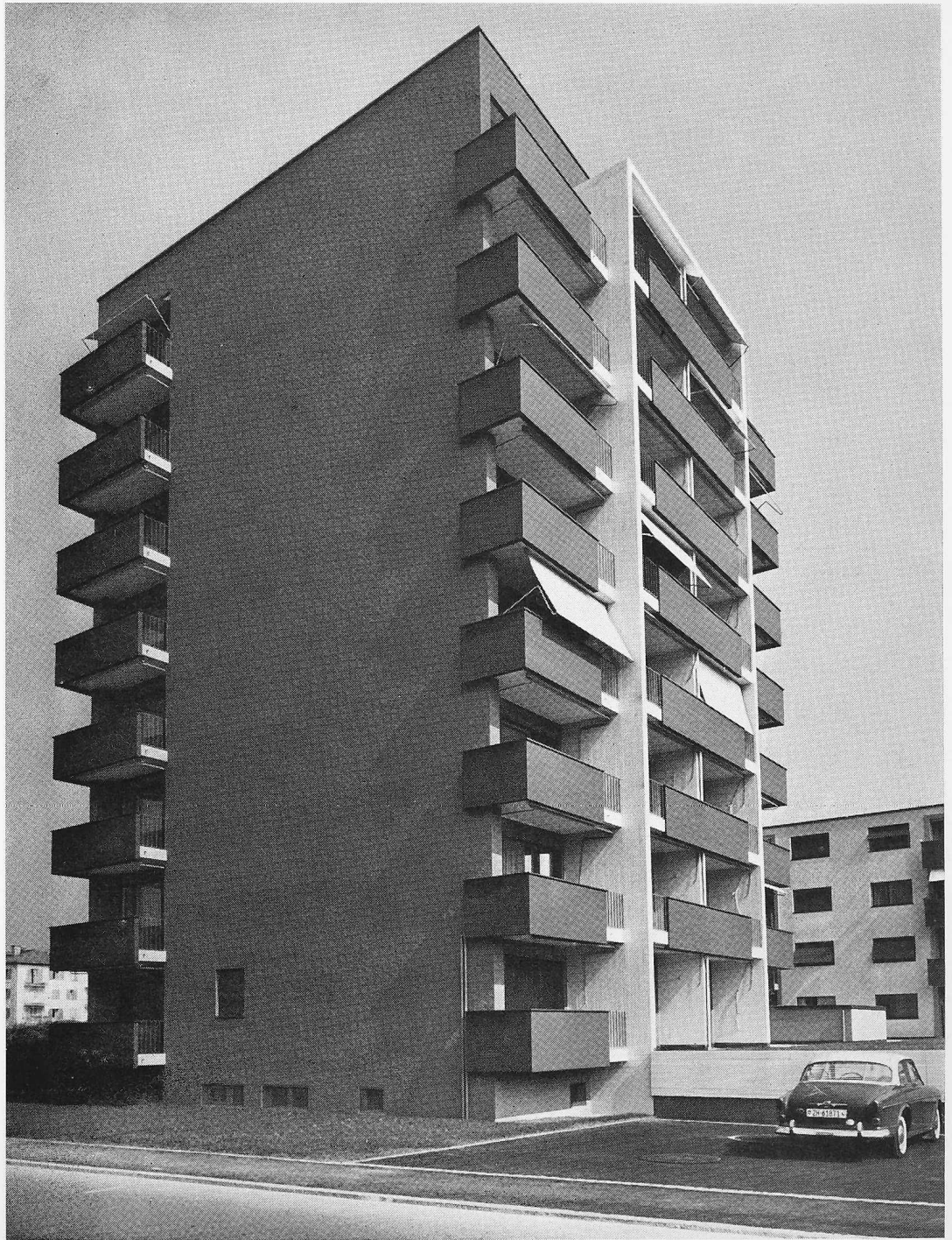
Der achtgeschossige Wohnturm aus Südwesten; im Hintergrund rechts viergeschossiger Block
