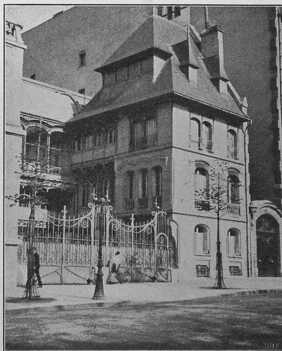
Abb. 10. Pförtnerhaus des Hauses in der Avenue Malakoff.
