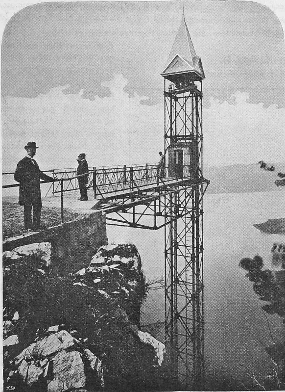
Abb. 3. Obere Plattform und Zugangssteg.
