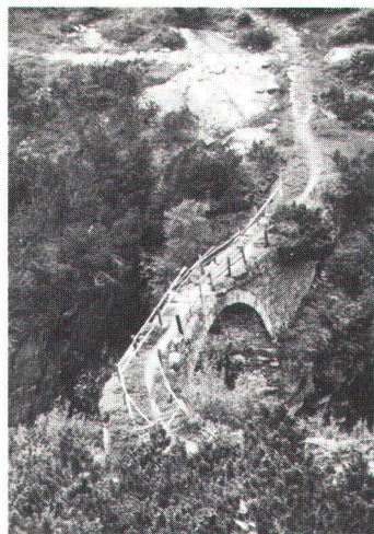
Die gewölbte Steinbogenbrücke über die Aare am Grimsel war ein Teil des mittelalterlichen Saumpfadens (Bild IVS).
