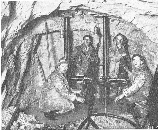
Abb. 4. „Ingersoll-Rand“-Bohrhämmer auf Spannsäulen.
