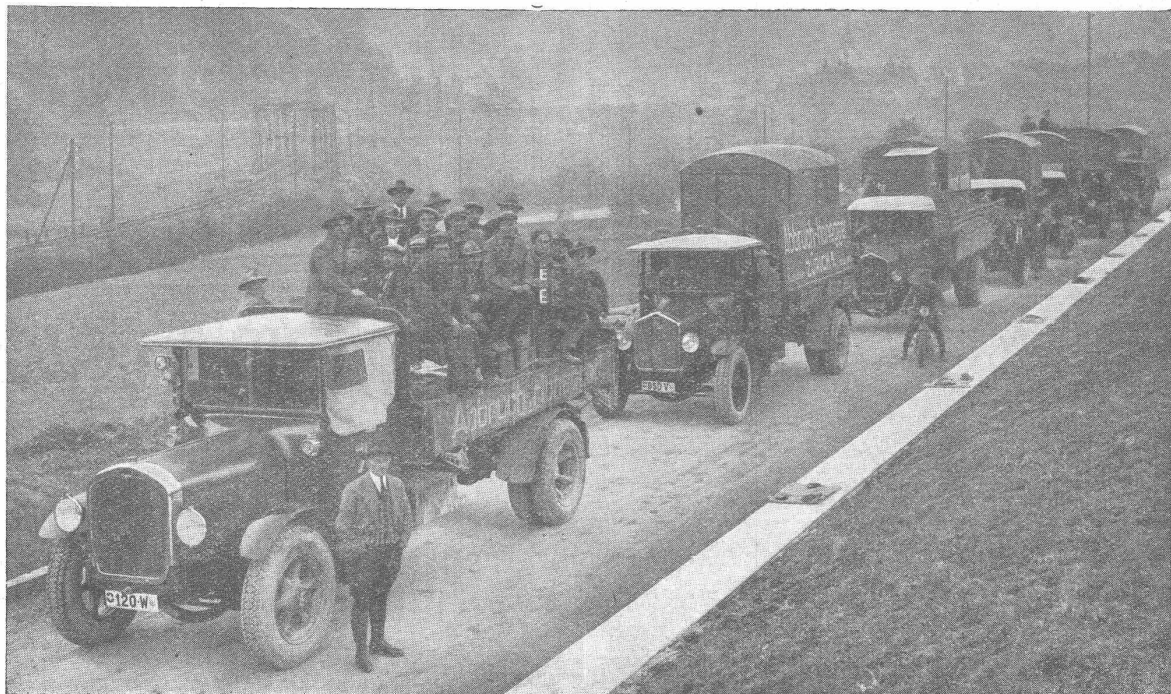
Sieben BERNA Kipper der aus zwölf BERNA bestehenden Kolonne für Abbrucharbeiten.
