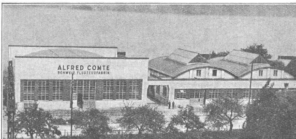
Flugzeugfabrik in Horgen 1700 m 2 Bitumitekt-Bedachungen grünschiefer-besandet
