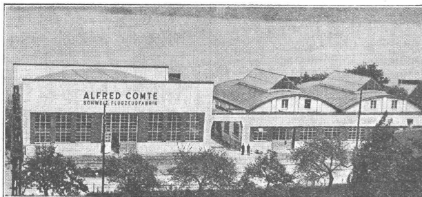
Flugzeugfabrik in Horgen 1700 m 2 Bitumitekt-Bedachungen grünschiefer-besandet
