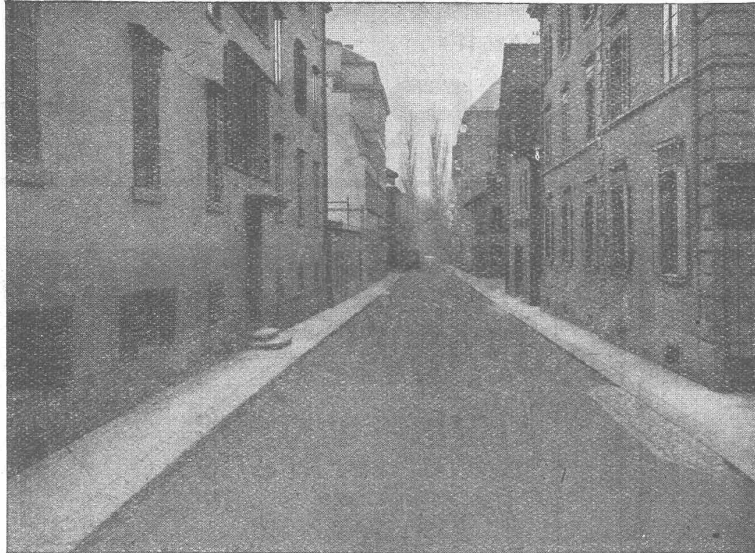
GLARNISCHSTRASSE ZÜRICH Walz-Asphalt: Topeka, 6 cm stark
