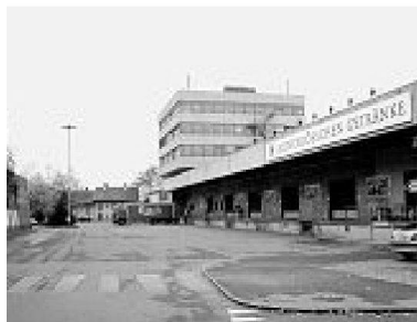
Schnellgutareal Wylerfeld. Ehemaliger Büroturm mit Speditionshalle. – Bild: Büro Mühlethaler
