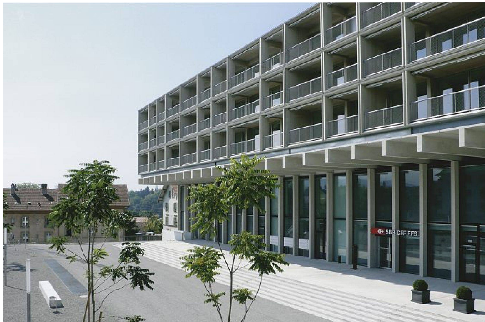
Vorplatz und Fassade von Osten. – Bild: Architektur fotografie Gempeler, Bern
