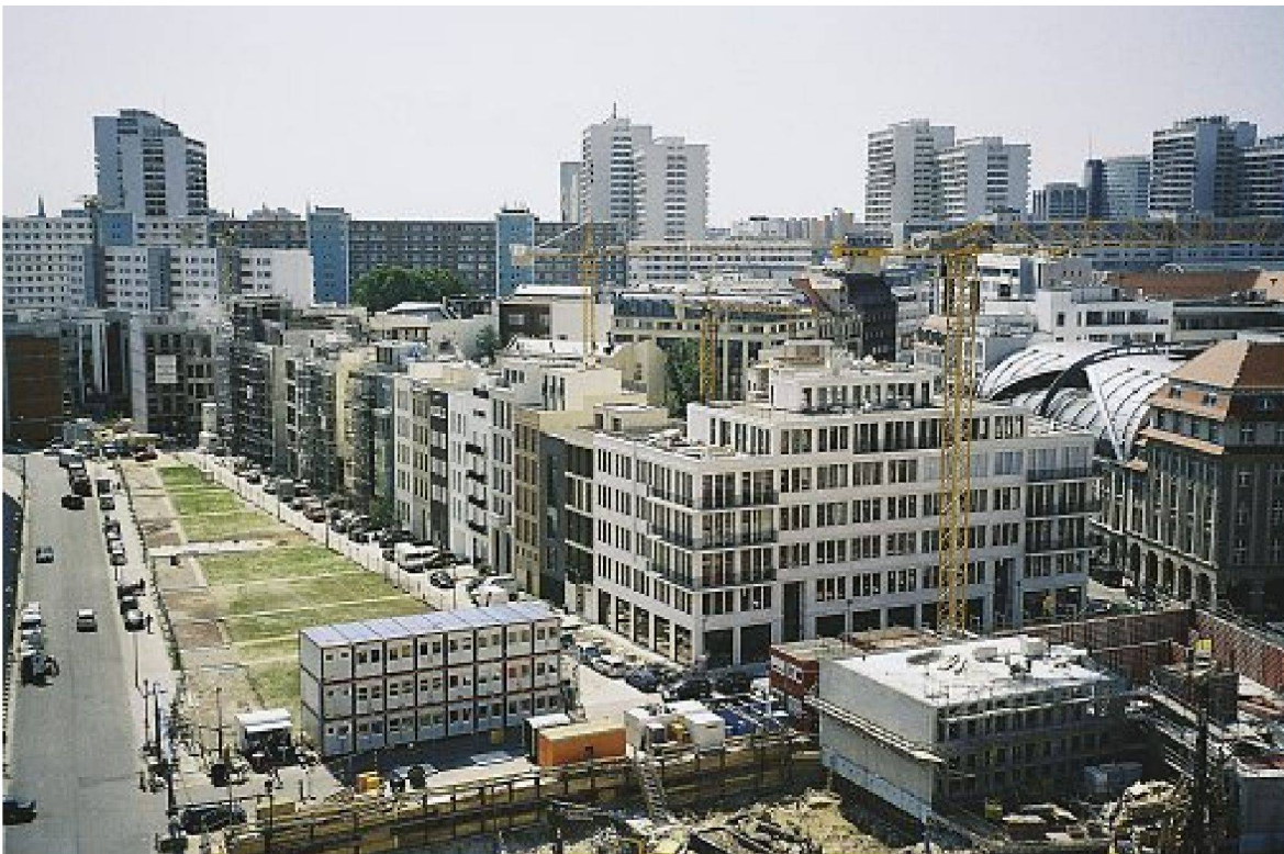
Friedrichswerder: Neue, kleinteilige Parzellenstruktur in der Stadtmitte. – Bild: DSK Deutsche Stadt- und Grundstücksentwicklungsgesellschaft mbH
