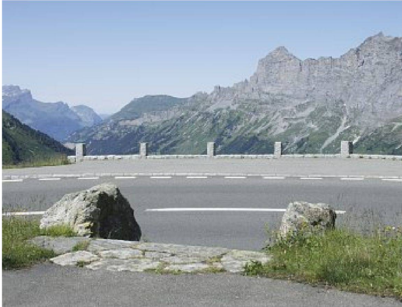
Wendeplatte Himmelsrank mit Ausstellplatz, Treppenabsatz zur Strasse und weiterem Ausstellplatz mit Wehrsteinen Typ B. – Bild: Isabel Haupt
