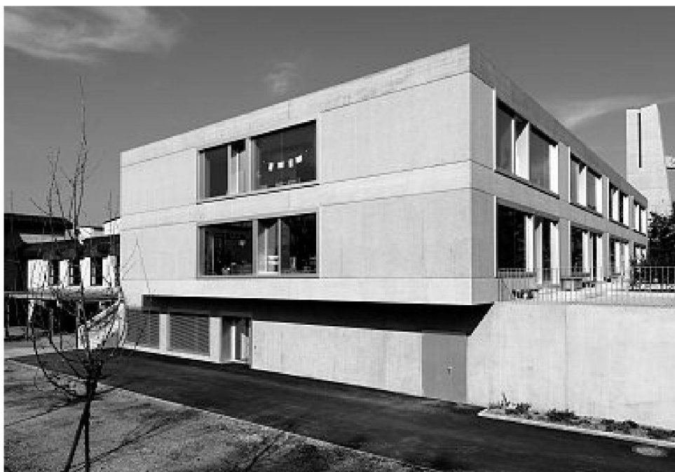
Leicht überkragende Südwestfassade des neuen Schultrakts
