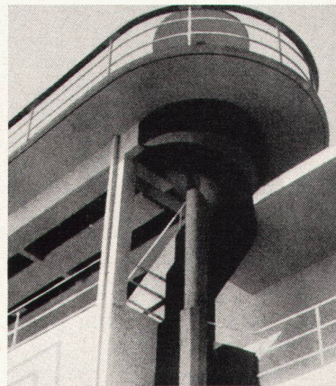
5 Projekt «Weiße Türme» mit aufgehängten Geschossen. Architekt: Saez de Oiza
